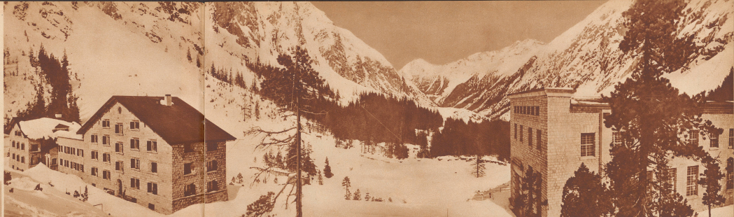
Hier in den Maschinen-Waldhäusern stehen die Zentralfabrik Linhard, Wyntental-Lauten und die «Schneebahn», welche L'habitation des machines de la centrale électrique de Handeck. 11 familles y passent l'hiver isolées du reste du monde. Le chemin de fer souterrain leur apporte deux fois par semaine le ravitaillement.
