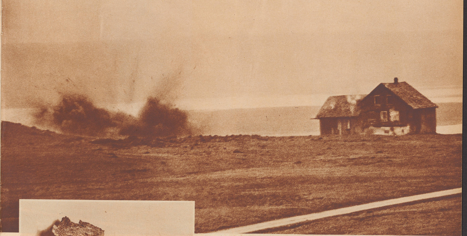
Eine 50 kg-Sprengbombe explodiert bei Momentan- oder Aufschlagzündung 30 m vom Versuchsobjekt entfernt. Die Wirkung war folgende: Luft und Erde erfuhren eine heftige Erschütterung, die auf eine Distanz von über 1 km deutlich wahrnehmbar war. Die Detonation war auf viele Kilometer weit hörbar. Am Gebäude wurden alle Fensterscheiben, die nicht entfernt worden waren, eingedrückt, eine Anzahl Dachziegel heruntergeworfen und die Mauern des Hauses durch Splitter beschädigt.
