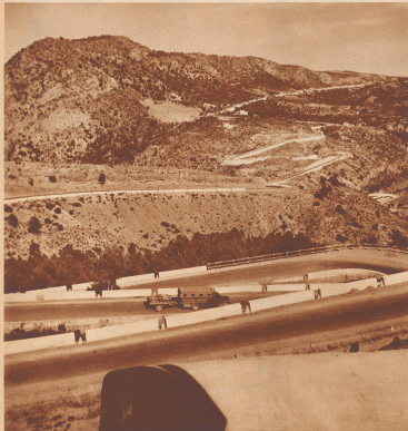
Kurz nach Valencia, in der bekannten Comata de Contreras, hat die Straße eine Höhendifferenz von 600 m zu überwinden. In wunderbar angelegten Kunstbauten führt die Route über den spärlich bewaldeten Berg. 122 km Teil sehr steiler Kurven gibt es dort. Die Gräben in den natürlichen Felsen und Jagdläger sind streng bewacht. Jedes Automobil muß sich vor der Fahrt über den Pass einer rigorosen Kontrolle unterziehen. Nur die Automobile der Schweizer Hilfe dürfen ohne Kontrolle passieren. Die Schweizer Chauffeurs haben den Überweg «Kampfbahn» gebaut.
