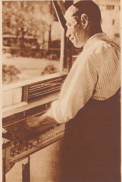
Herr Seiler leitet seine Lötschbergbahn von der Schalttafel aus. Er kann hier 14 Weichen stellen und 18 Spielleitungsschalter und verschiedene Signale bedienen.
