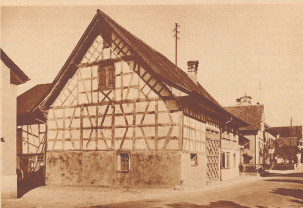
Im Dorfe Langwiesen an der Hauptverkehrsstrasse Schaffhausen-Diessenhöfen wird gewöhnlich, die Straße verfahren und ein Gefolge erfüllt, kein diese kleine Kriensberg, in dem die Bauernhäuser zu weiten, rein als Verkörperungen zu sein in die Straße hinaus. Sobald die Exportation-Verhältnisse zwischen Staat und Grundstücksmitteln abgeschlossen sind, wird das Haus abgehoben. Celle maison à hardes de Langwiesen (Zürich) est à la veille d'être expropriée par l'Etat et détruite, pour les besoins de la circulation.
