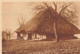
In argentinischen Kirchenbau nicht ein einziges Strohhalm, das wegen Bauartigkeit demselben abgrenzen werden soll. Die Wohnräume, eine Stube mit zwei Nebenräumen und Küche, reichen mit Stall und Scheune unter demselben Strohhalm. Da war dem Hausbau nicht mehr möglich, diese Haus, einer der selten gewordenen Strohhalm im Argentin. In die Niederwelt zu erhalten. Diefere Strohhalm dürfen übrigens nicht wieder mit Strohhalm trennen werden, sie müssen gemäß brennstofflichen Verfassung ihre Stöben mit modernen Ziegeln decken. Quelle: merveilleux paysanne, que cette ferme au toit de chaume de Kriensberg (Argentin). On parle pourtant de la détenir, car elle présente des dangers d'effondrement.
