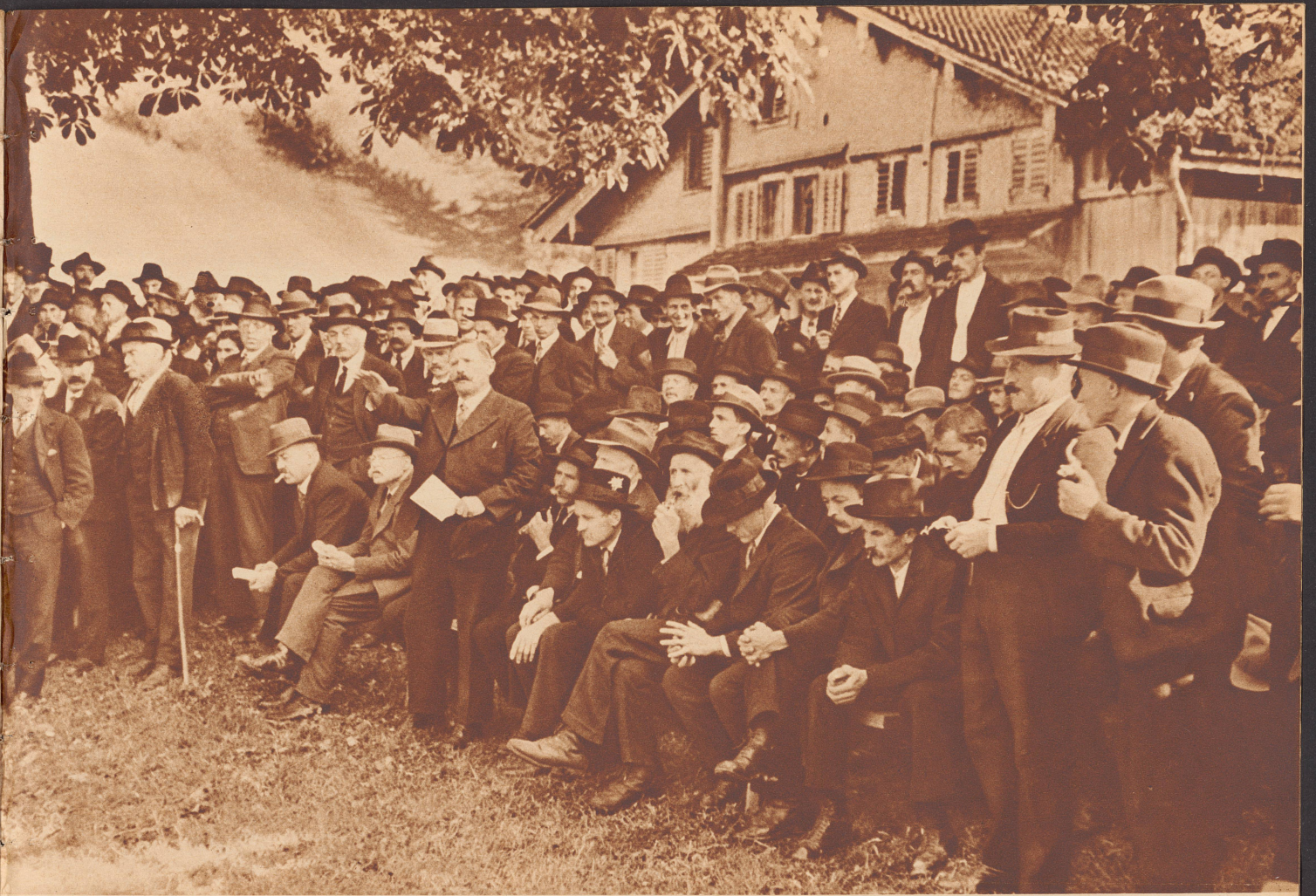
Jedes Geschäft, sei es so winzig wie das Gesuch eines Genossen um Platz für einen Stallanbau, sei es so wichtig, wie die 101 000 Franken kostende Bergbachverbauung, die 100 000 Quadratmeter neues Wiesland erschließen soll, muß in der Öffentlichkeit vorgebracht werden — nichts darf hinter geschlossenen Türen geschehen. Qu'elle soit minime ou d'une grande importance, qu'il s'agisse de l'emplacement d'une écurie ou d'un subside de 101 000 francs pour l'entretien du bien communal, chaque affaire est discutée au grand jour.
