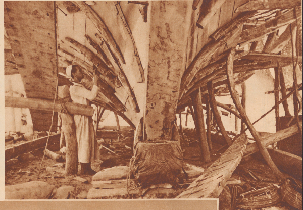
Arabische Booten im neuen Bauzustand. Schon sichtbar ist der Rumpf des Dreihundert-Tonnen-Seglers ab. Die Innenwand des Schiffes wird verschalt. En chantier, voici le coque intérieure d'un bateau de 300 tonnes.
