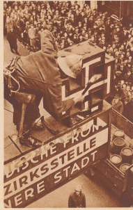
La Wien: Das Krakenkreuz... vereinsamt. Von Feuerwehrmännern wird das Symbol des Ständestaates Österreich von den öffentlichen Gebäuden entfernt. Fests Austria... La croix gammée, symbole de l'Autriche, est enlevée des édifices publics par le soin des pompiers.
