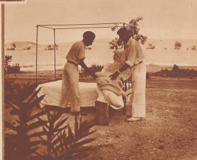
Das Klima in der Syrischen Wüste ist außerordentlich 40-50 Grad Wärme und keine Schmelze, deshalb schließt die Anstellung der Pumpstation die größte Zeit des Jahres im Freien. 40 bis 50 Grad C. sont choies fréquentes dans le désert syrien. On couche dehors ou sur les toits des bungalows.
