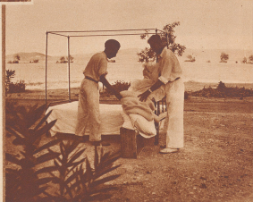
Die Klima der Syrischen Wüste ist aufsehend: 40–50 Grad Wärme und keine Schmelze, deshalb schließt die Anstellung der Pumpstation die größte Zeit des Jahres im Freien. 40 bis 50 Grad C. sont choies fréquentes dans le désert syrien. On couche dehors ou sur les toits des bungalows.
