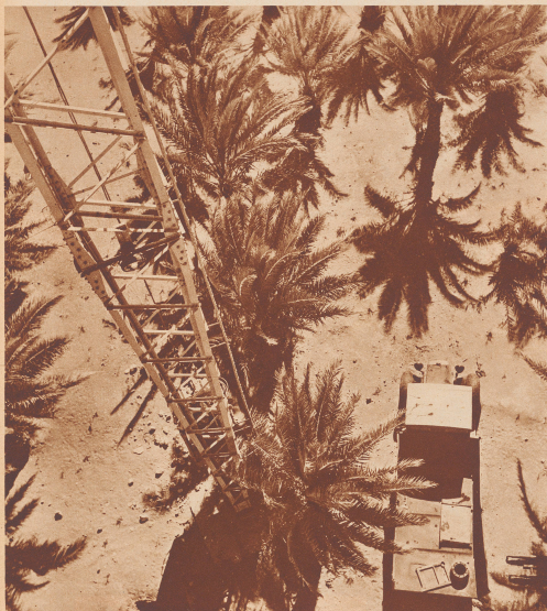
Zum Überqueren der vier großen Wasserläufe Euphrat, Tigris, Jordan und Orontes wurden die Leitungen von einem in Höhe eingegraben, im Flußbett verankert oder an hohen Eisenklettermasten 18 bis 24 Meter gehöhrt. Erstere sind beim Jordan und beim Orontes der Fall, letztere beim Euphrat und beim Tigris. Das Bild zeigt, mitten in den Palmen, einen 40 Meter hohen Lattenturm bei Haditha am Owerflur des Euphrats, wo die Rohre auf eine Distanz von 800 Metern frei in der Luft hängen.
