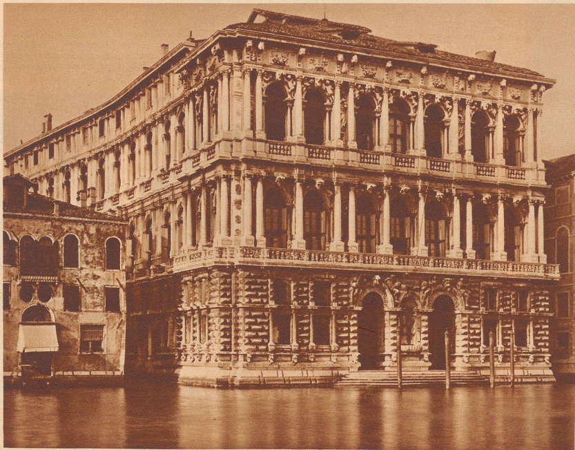
Palazzo Pesaro am Canale grande, eine der genialen Schöpfungen Baldassare Longhenas. Heute ist der Palast in den Besitz des italienischen Staates übergegangen, der hier Kunstausstellungen veranstaltet. Le palais Pesaro sur le grand canal, actuellement propriété de l'Etat, œuvre de Longhena.
