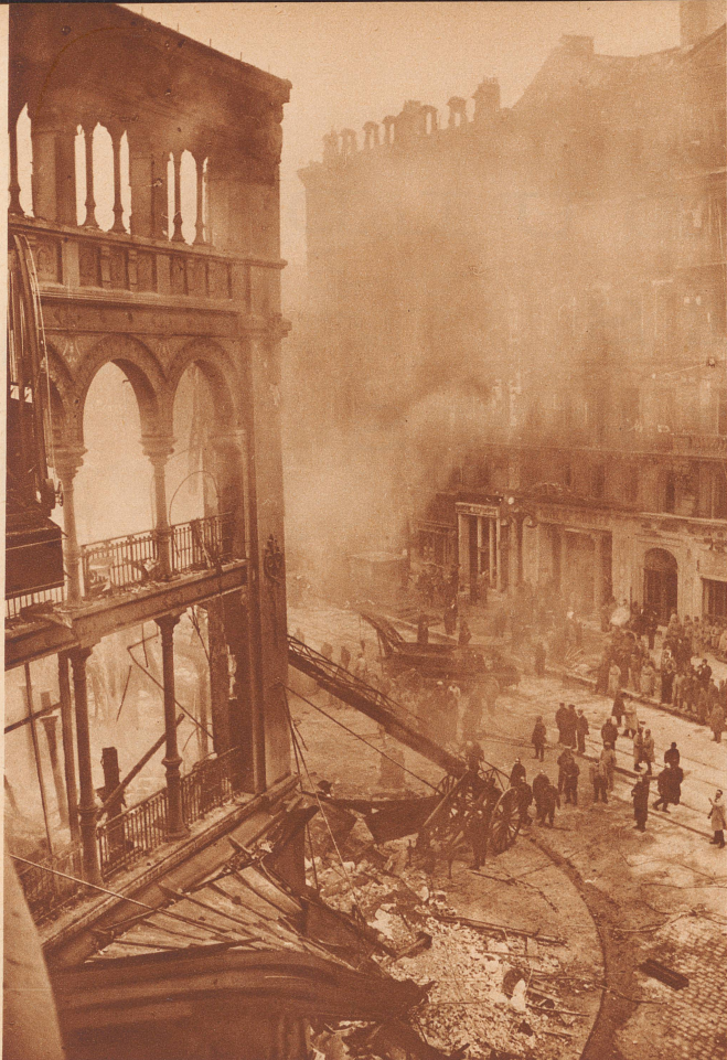
Das ausgebrannte Warenhaus «Nouvelles Galeries» an der Canebière, der Hauptstraße von Marseille, aufgenommen Samstagvormittag, nachdem der Brand Freitag, den 28. Oktober, um 14 Uhr ausbrach. Das vierstöckige Gebäude, ein Komplex von 120 Meter Länge und 40 Meter Tiefe, wurde im Jahre 1900 erbaut. Gegenüber das Hotel de Noailles, auf das das Feuer auch übergriff und dessen Dachstock ausbrannte. Der bis jetzt festgestellte Schaden beziffert sich auf rund 30 Millionen französische Franken.
