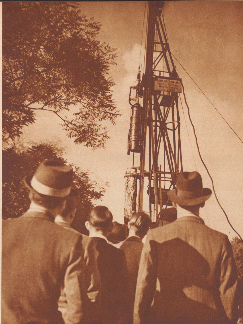
Die Zürcher Quaibrücke wird erweitert. Weithin hörbar rammt der Dampfhammer mächtige Pfähle in den Seegrund. Ein ganzer Wald wird hier in den Boden getrieben, 200 Stämme, die 18 bis 24 Meter lang sind. Das wuchtige Tun des Hammers zieht täglich viele Leute an. Unter ihnen stand auch ein Dichter. Er schrieb das untenstehende Gedicht.
