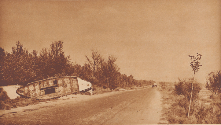
Der Tank am Straßenrand
