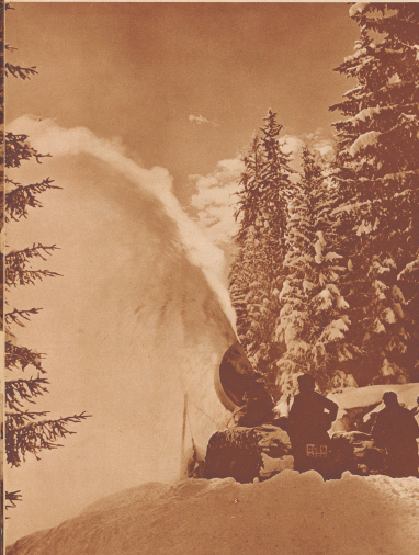
Sind ganz außerordentliche Schneesengen gefallen, dann kann dem Motorschlittenzug für die ersten Fahrten eine Schneeschleife beigesteuert werden, die ebenfalls eine neuartige und erstmalige Bauweise zeigt.
