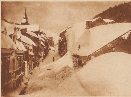
Plusieurs avalanches ont déferlé sur Barèges (Hautes-Pyrénées), dont la première fit 27 victimes. Par mesure de précaution, le village a été évacué.
