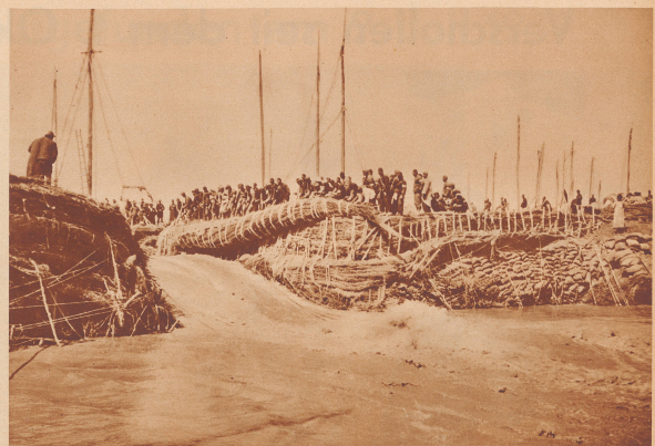
Das Dammbau geht einem Ende entgegen. Eine Lücke von 10-12 Meter Breite ist noch zu schließen. Mit großer Wucht schaffte das Wasser durch die Öffnung; darum ist diese Endphase die schwierigste Stück Arbeit. Eben wird eine der letzten mächtigen Fäden als sogenanntes Seilstück ins Wasser gelassen. Diese Fäden sind hergestellt aus 12-15 Meter langen Weiden, ausgefüllt mit Erde und Kien und zusammengehalten mit dicken, auf dem Platze hergestellten Stricken. Zehntausende von toden Fädenwurden wurden bei diesem Dammbau zum Schutze des Lehmkerens benötigt. L'eau qui s'écoule avec violence rend difficile l'achèvement de la digue. Pour réaliser des fondements qui résistent à la force du courant, on immerge de longs bouquets de roseaux qui consistent des branches. Et la terre et les pierres, maintenus par des cordes.
