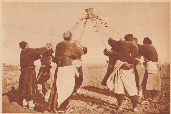
Der „Adermannsbilger“ in Tätigkeit. Ein uraltes Instrument, mit dem der Damm fertiggestellt wird. Acht Mann schleudern den ungefähr 60 Kilo schweren Schlager in 3 Meter hohen Schalen in die Luft und lassen ihn auf die Erde niederfallen. Rund 2 Millionen Kubikfuß Erde wurden so bei diesem Dammbau nicht der Dampfmaschine, sondern von Hand festgestampft. Ces casse de sol. Huit hommes soulèvent à force de bras, au moyen de cordes de 3 mètres, ce poids de 60 kilos qui tient lieu de pilon.
