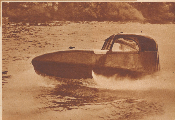
Ein neuer Bootstyp, den man fast für ein Auto halten könnte. Dieses Motorboot dient der Flusspolizei in England und erlaubt eine Stundengeschwindigkeit von ungefähr 60 Kilometer.
