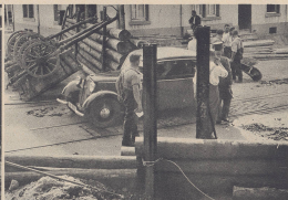
Sperrung einer breiten Hauptverkehrsader mittels T-Halkengittern und Eisenstachelbarricade. Die Straßensperre verleiht noch längere, und hier die Automobile nur eine schmale Passage freigelassen. Pénoreuse d'une grande voie de circulation au moyen de poutres en fer et de troncels d'acier. Le ramway circule encore sur une voie et un étroit passage est réservé aux automobiles.
