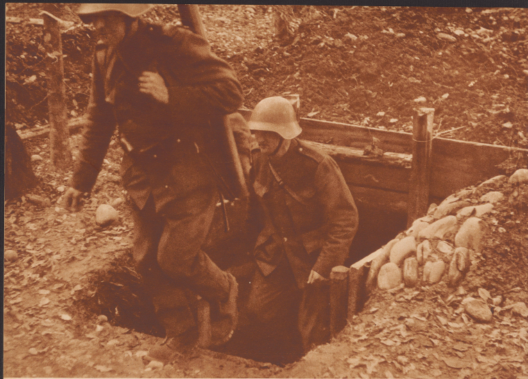
Rückwärtiger Ausgang aus einer belagerten Stellung. — Sortie arrière d'une position fortifiée.
