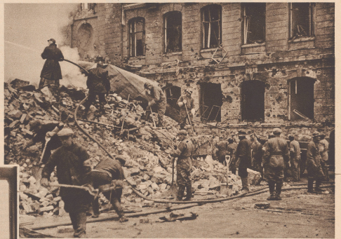
Hier stand am 1. Dezember, vormittags 10 Uhr, noch ein vierstöckiges Wohnhaus. Jetzt sind Polizei und Feuerwehr dabei, unter den raschenden Trümmern die sechs Personen zu suchen, die beim Einsturz des Hauses ihren Tod fanden.
