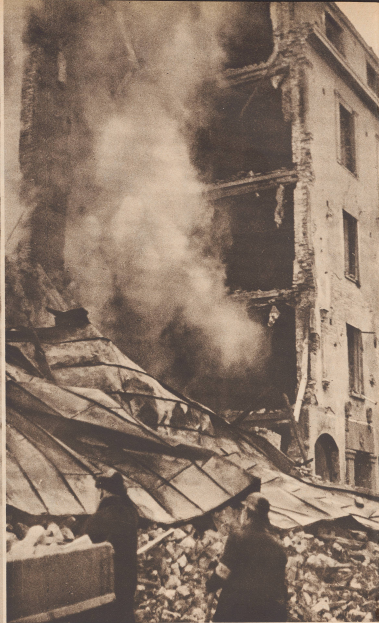
Die Wirkung einer russischen Fliegerbombe. Sie durchdrang fünf Stockwerke dieses Mietshauses, explodierte im Keller und brachte das ganze Haus zum Einsturz. 14 Menschen, die zum Teil im Keller Schutz gesucht hatten, wurden getötet. Im ganzen forderte dieser erste Luftangriff auf Helsinki über 80 Todesopfer.
