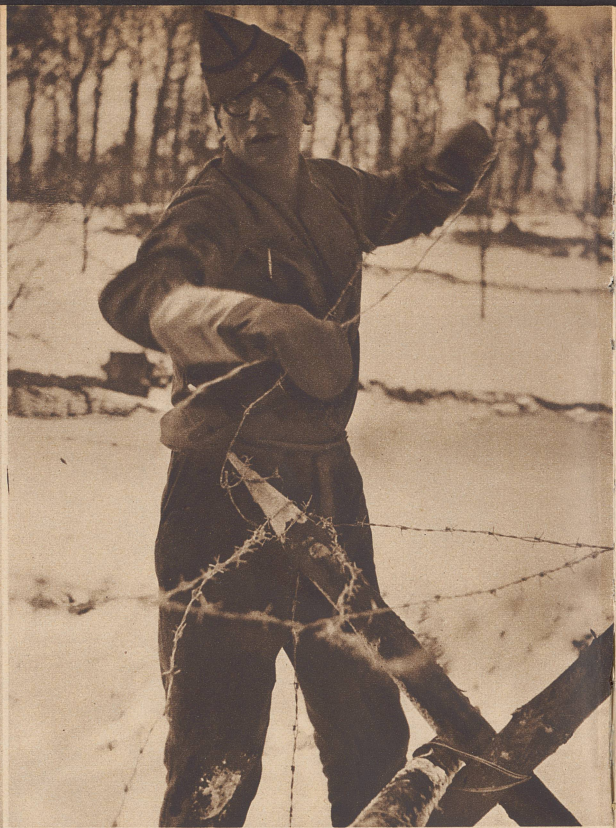
Ein Sappeur überzieht spanische Reiter mit Stacheldraht. Wollhandschuhe sind bei dieser Arbeit ungeeignet! Le montage des barbelés sur de solides chevalets de bois.
