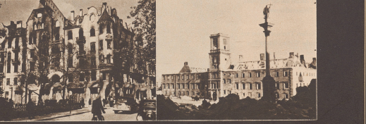
Die Überreste einer Häuserzeile im Villenrevier Mokotów. Rechts der Mauerabschnitt des polnischen Botschafter, das keinen Schaden bei der Beschießung haben. Les ruines d'une rangée de maisons de quartier Mokotów. À droite, la muraille du quartier polonais, par laquelle, échappé au danger.
