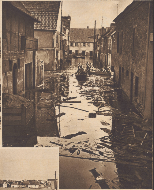
Das Dorf ist seit Beginn des Krieges von der Zivilbevölkerung evakuiert, aber doch noch von einem kleinen Detachement Corps-Franco-Leute besetzt, die den einzigen Verkehr durch die Straßen mit Booten bewerkstelligen. Dans les rues de village évacué, des détachements de corps francs parcourent en bateau.
