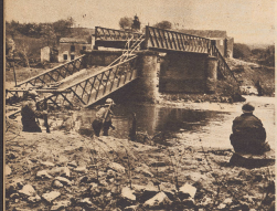
Von den Franzosen gesprengte Brücke irgendwo an der Front von Lothringen. Pont détruit sur un petit cours d'eau de Lorraine.
