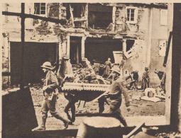
Abbruch eines von Bombentreffern schwerbeschädigten Hauses. La troupe déblaise une maison éventrée.
