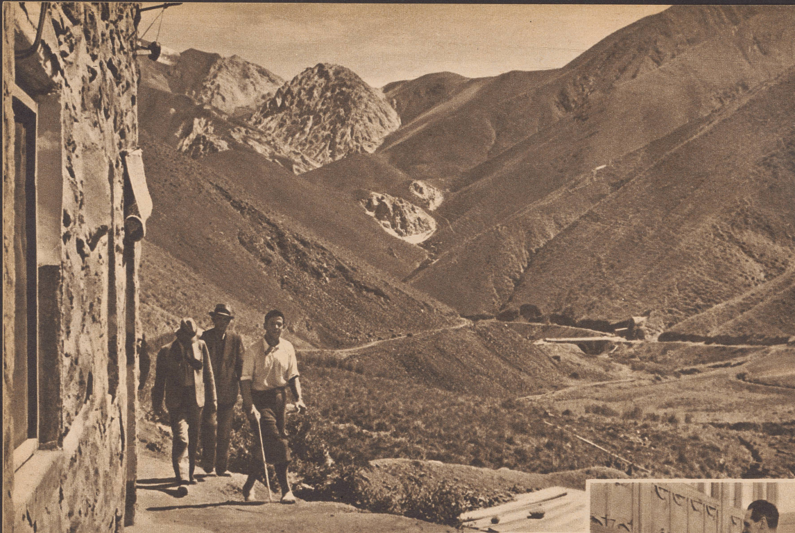
An der Schalus-Straße, die Schah Reza Pahlevi bauen ließ, um eine kürzere Verbindung von Teheran über das Elburs-Gebirge an das Kaspische Meer zu erhalten. Ingenieur Lötscher, ein Schweizer, mit seinen Vorarbeitern.
