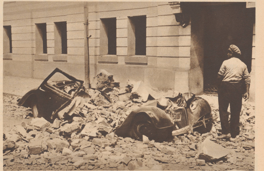
Total zerstörtes Automobil das vom herabstürzenden Gerüst getroffen wurde. Von diesem Hause wurde das obere Stockwerk vom Boden beinahe vollständig abgetrennt und auf die Erde geworfen, während die unteren Stockwerke und besonders das Erdgeschoss relativ wenig Schaden nahmen. Une automobile écrasée par les pierres d'un immeuble sont ibasés.
