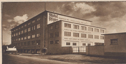
Teilansicht einer neuen Fabrik in Suhr bei Aarau
