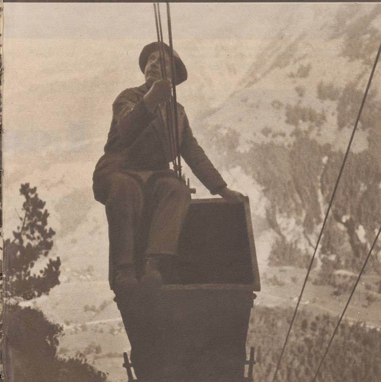
Der Transport der abgebauten Kohle aus den Stollen ans Tageslicht erfolgt mit Rollbahnen, die Beförderung zu Tal mit Hilfe einer Seilschwebbahn. Die schwindelfreien Arbeiter benützen die Seilschwebbahn auch zur Fahrt von und zur Arbeitsstätte. Le charbon extrait de la galerie est chargé sur des wagonnets Decauville puis acheminé vers la vallée au moyen d'un téléphérique.
