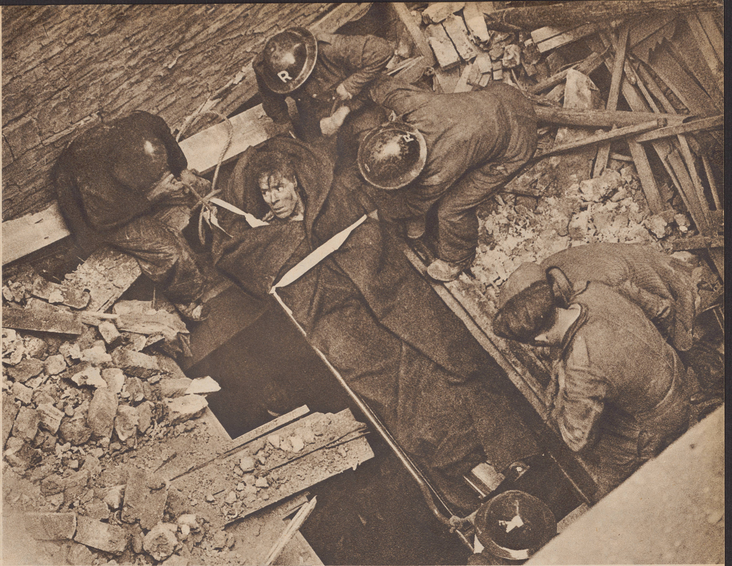
Um 10 Uhr nachts wurde das Haus von einer Bombe getroffen, stürzte ein und begrub eine Anzahl Bewohner unter den Trümmern. Um 17 Uhr des folgenden Tages wurde als letzter der Verschlütteten Mr. Painter geborgen. Er war mit beiden Beinen zwischen zwei Balken eingeklemmt. Sein Hund, der mit ihm begraben war, verriet durch anhaltendes Bellen die Lage des Mannes. Seine ersten Worte, als er nach 17 Stunden von den Männern des Rettungsdienstes ans Tageslicht gebracht wurde, waren: «Es tut mir leid, daß ich Ihnen Mühe machen muß!»
