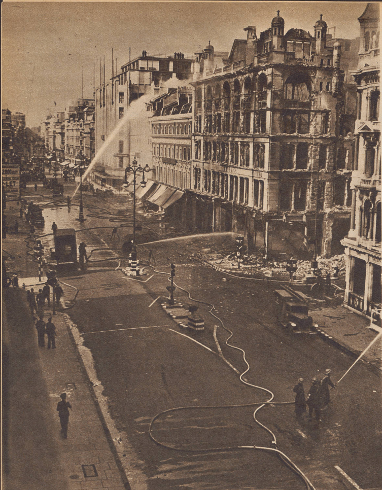
Blick in die Oxfordstreet, die große Londoner Geschäftsstraße. Das ausgebrannte Haus rechts ist das bekannte Warenhaus Lewis, das die Nacht zuvor von einer Anzahl Brandbomben getroffen wurde. Dans Oxford-street, la grande artère commerciale de Londres. La maison brûlée est le célèbre magasin Lewis, touché durant la nuit par des bombes incendiaires.
