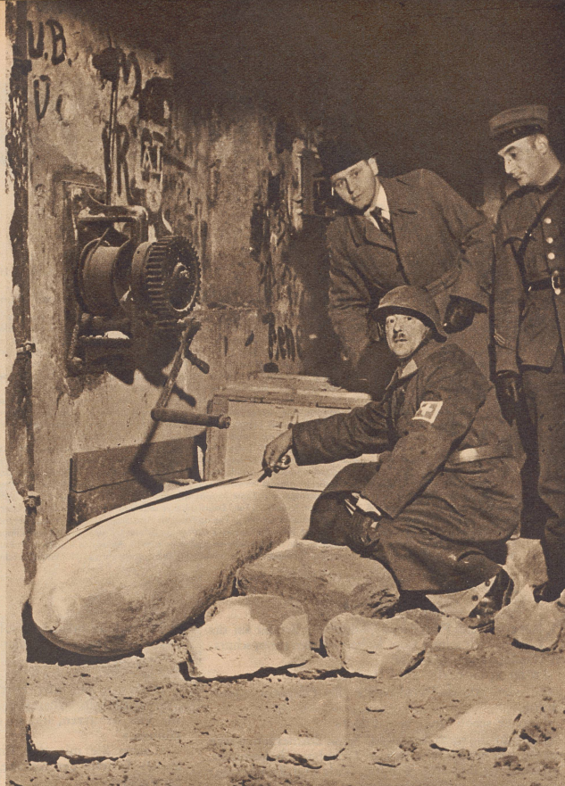
Ein Blindgänger. Er fiel neben das Haus Güterstraße 167, durchschlug das Fundament, drang von der Seite in den Keller ein und blieb dort liegen. Die Bombe ist 1,30 Meter lang, hat einen Durchmesser von 55 cm und wiegt 500 Kilogramm.
