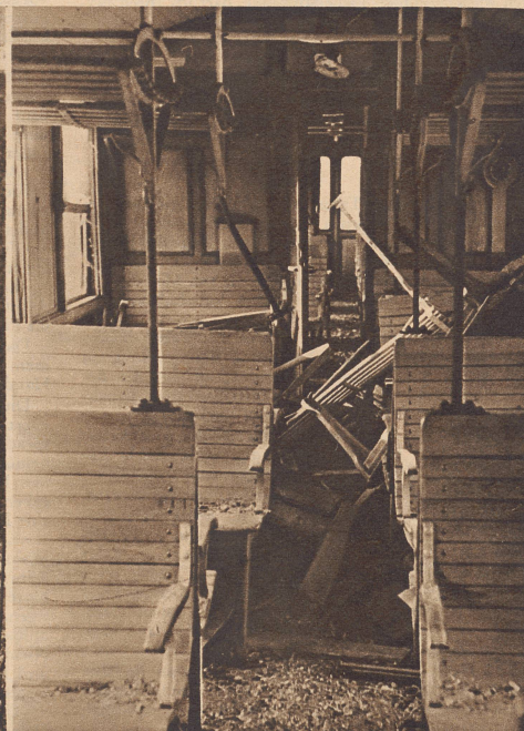
Einige Bomben fielen auf das Areal des Bundesbahnhofes. Sie zerstörten zwei Geleise und richteten großen Schaden an dort stationierten Personenwagen an.
