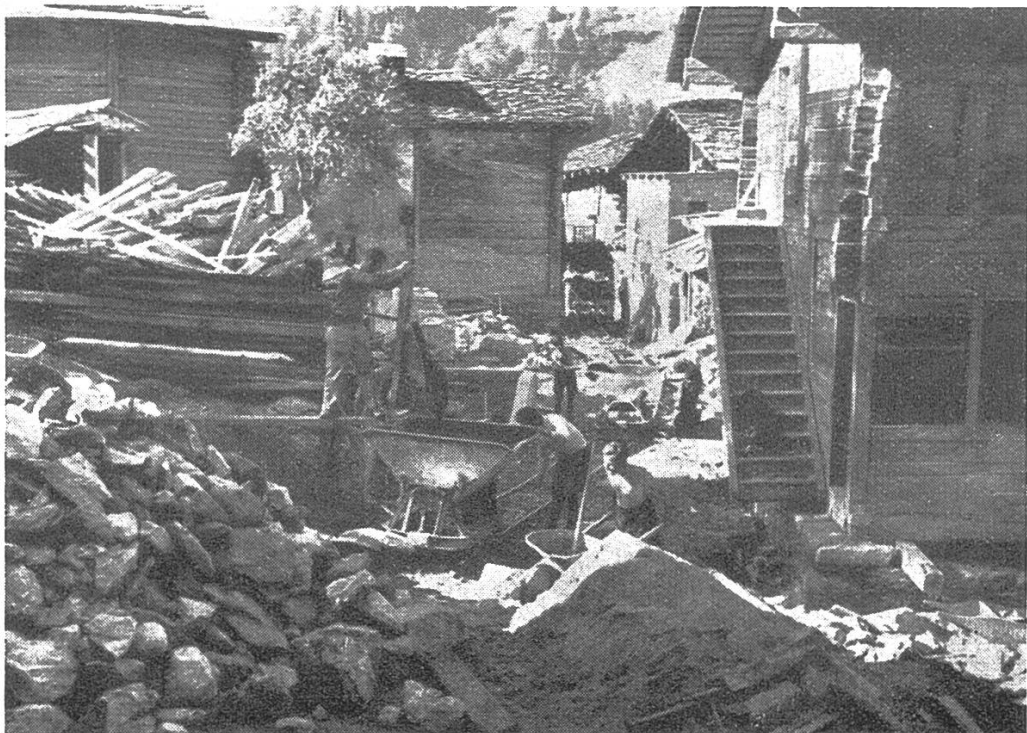
Aufräumarbeiten in Lourtier
