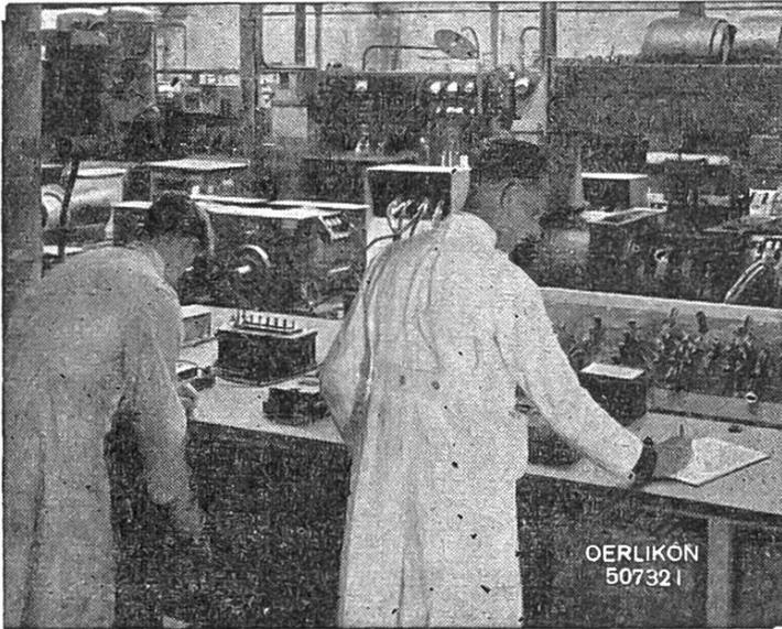
Im Versuchslokal erfolgt die Prüfung elektrischer Maschinen und Apparate auf richtiges Funktionieren und Einhalten der Garantiewerte.
