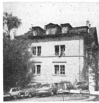
soll abgebrochen werden.
