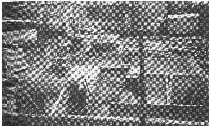
Die Kellermauern sind bereits betoniert
