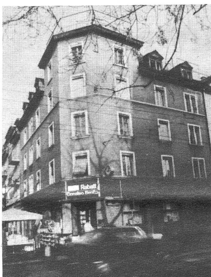
Wann das Woko-Haus an der Ecke Josefstr. 102/Langstr. (der „stinkend-brodelnden Aorta Zürichs“, wie sie einmal in der ZS genannt wurde) abgerissen wird, ist ungewiss. Sicher ist jedoch, dass dann 17 bezahlbare Zimmer dem Baggerzahn zum Opfer fallen werden.
