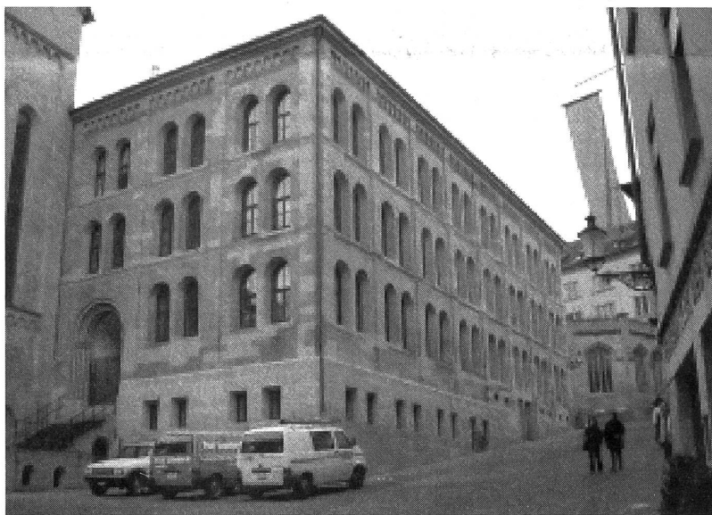
Abgeschieden vom Rest der Universitätsgebäude: Das Theologische Seminar an der Kirchgasse
