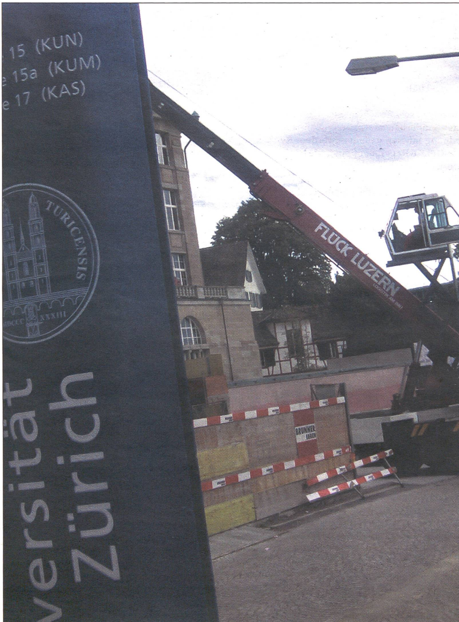
Wird hier bald noch viel mehr gebaut? Baustelle Uni.
