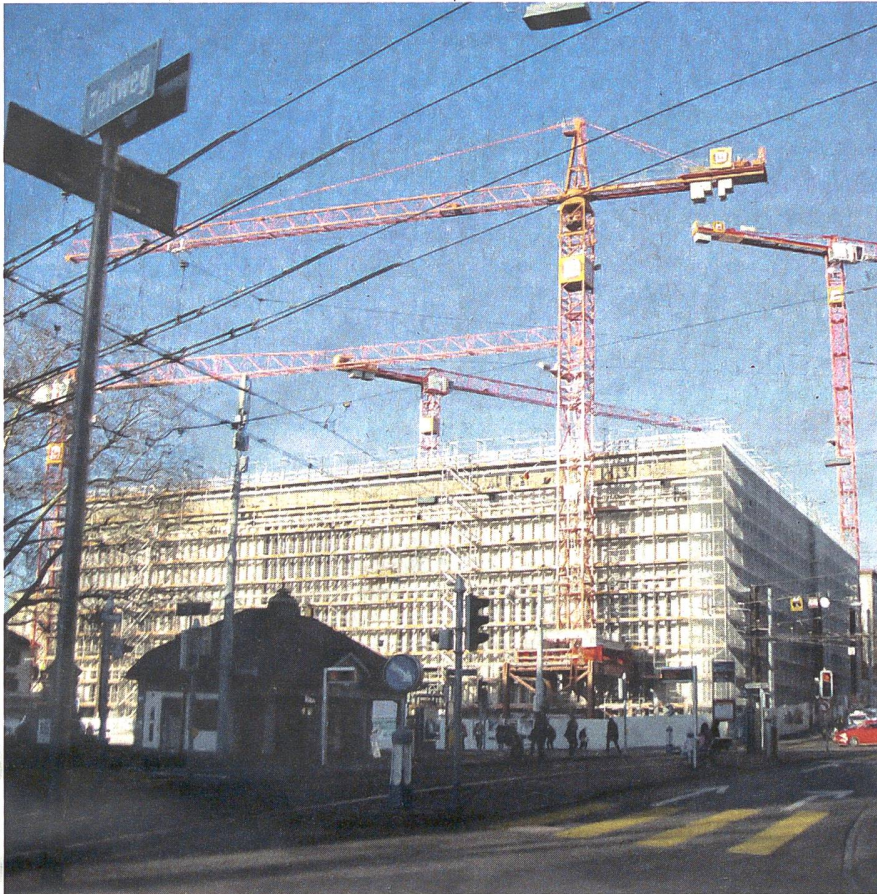
Hier entsteht das grösste Kunstmuseum der Schweiz.
