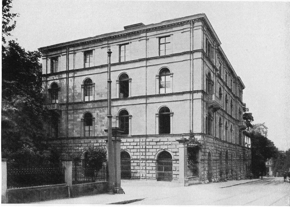
Geschäftsbaus Fierz, jetzt Gerichtlich-medizinisches Institut der Universität Zürichbergstrasse 8, Ost- und Strassenfassade Erbaut nach Plänen von Gottfried Semper 1865—1868
