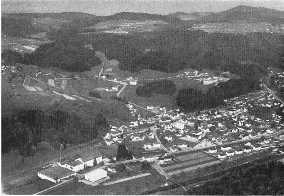
Flugaufnahme von Kollbrunn. Im Norden das Heidertal. Links im Bilde Töbeli und Tößwies mit der Fabrik Ed. Bühler. Flugaufnahme Werner Friedli, 1963. Photosammlung Stadtbibliothek Winterthur.
