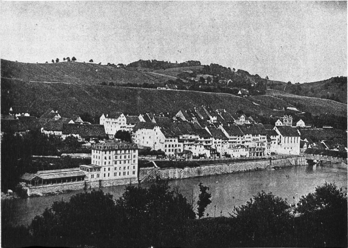
1919 Das Kurhaus kurz vor dem Abbruch der Holzbrücke
