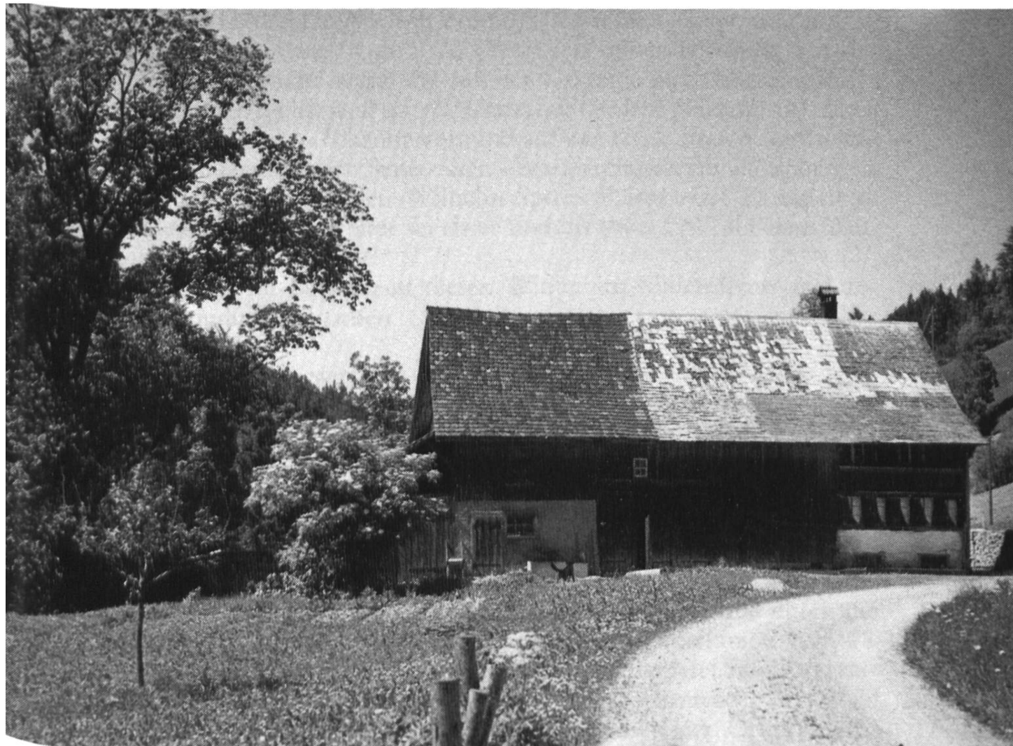
Das Haus im Burri, Steg-Fischenthal, abgebrochen 1953
