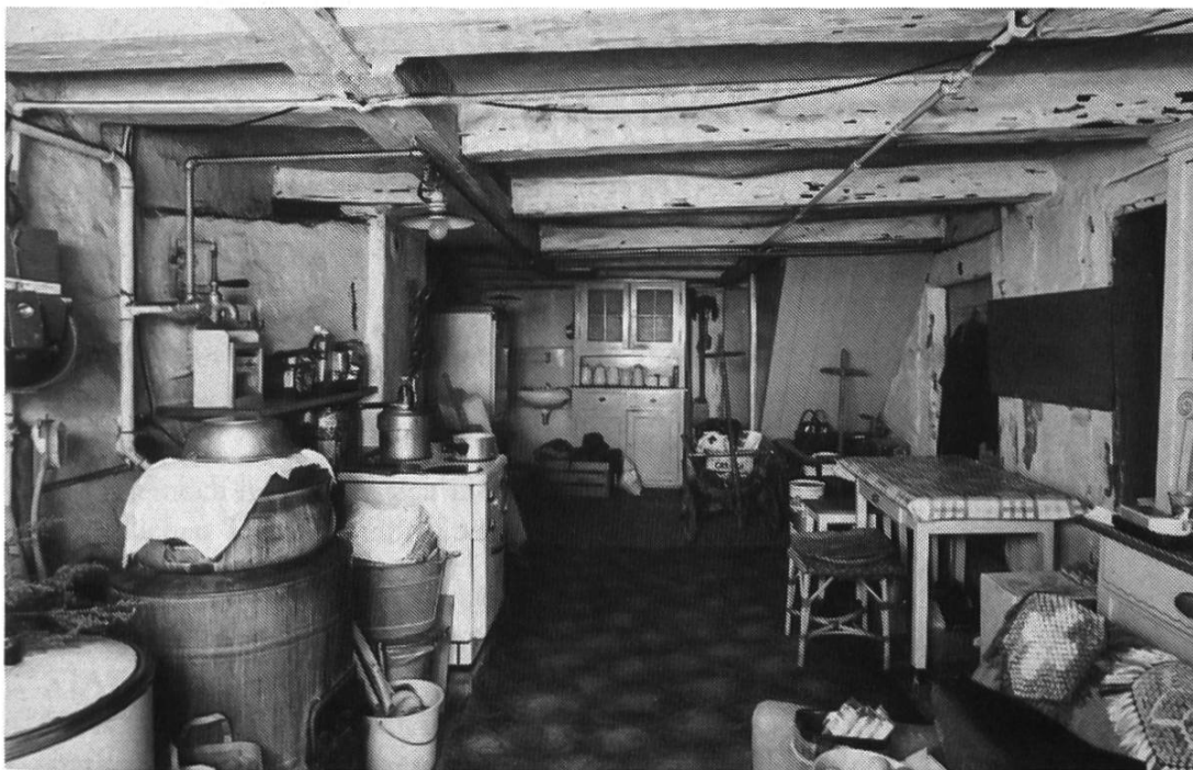
Abbildung 8: Blick in die Küche vom Eingang her: Die Balkendecke wurde beim Umbau von 1785–1787 eingezogen; vorher war der Raum bis unter das Dach offen. Rechts im Hintergrund der Ausgang zu den oberen Räumen.
