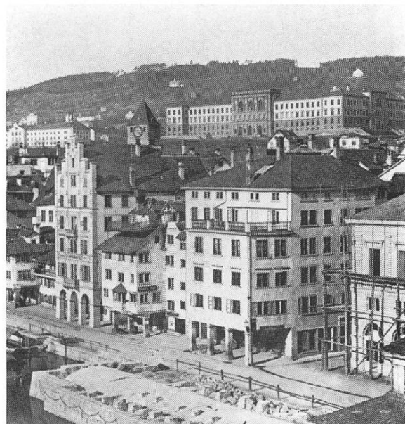
Abb. 16: November 1864, das Gerüst wird abgebaut; das Fundament für die neue Fleischhalle ist im Bau, das alte Schlachthaus ist noch nicht abgebrochen.
