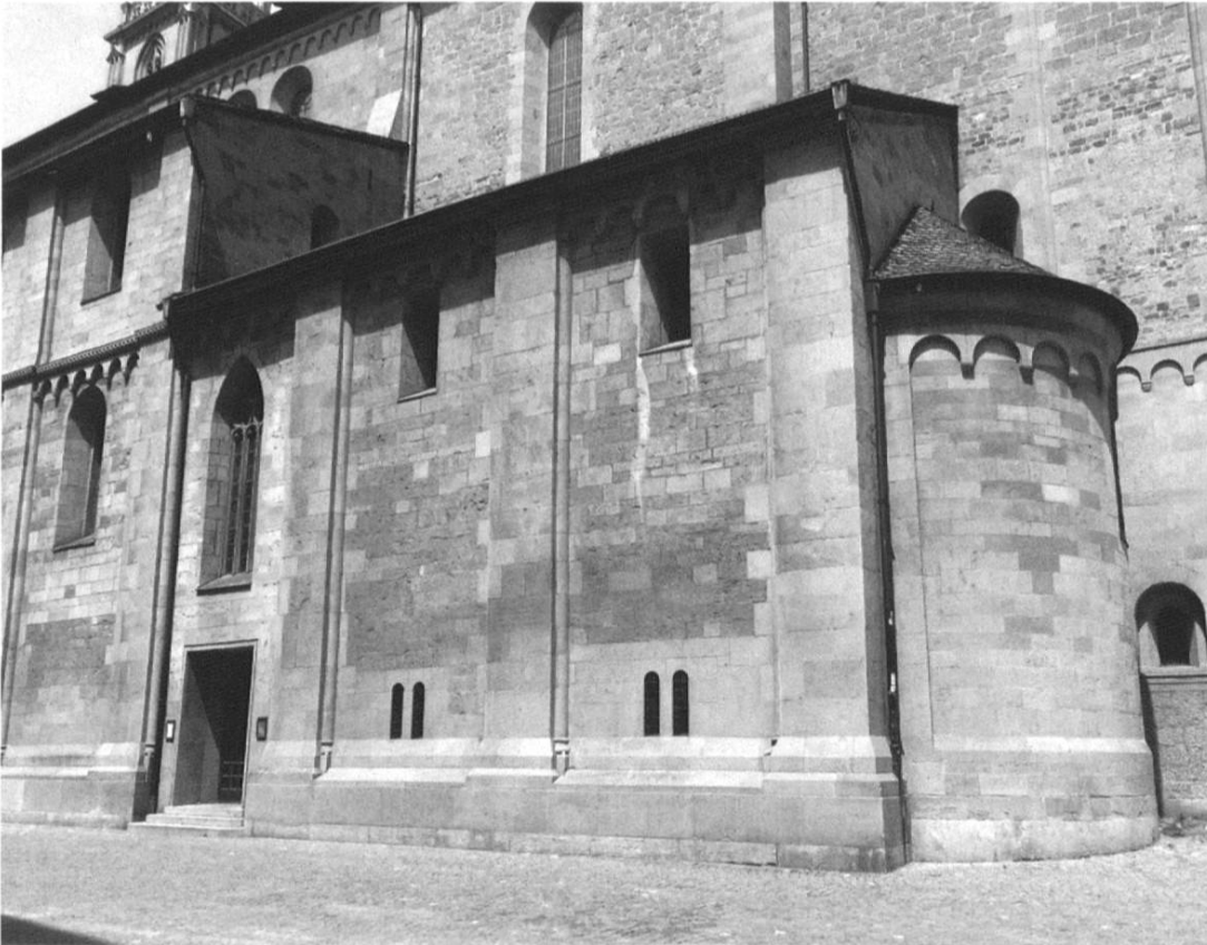
Abb. 1: Die dreijochige Zwölfbottenkapelle des Grossmünsters mit dem Sakristeieinbau als oberem Geschoss im mittleren und östlichen Joch (erkennbar an den beiden Rechteckfenstern), wo sich bis 1837 das städtische Urkundenarchiv befand (Foto: Christian Sieber).
