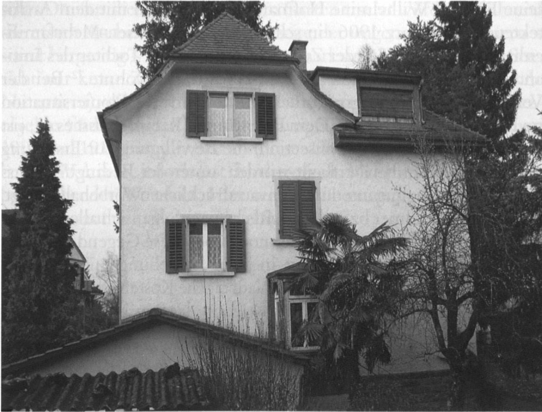
Abb. 9: Haus Rainstrasse 35, 1906 erbaut, 2007 abgetragen. (Aufnahme 2006, S. Brändli.)
