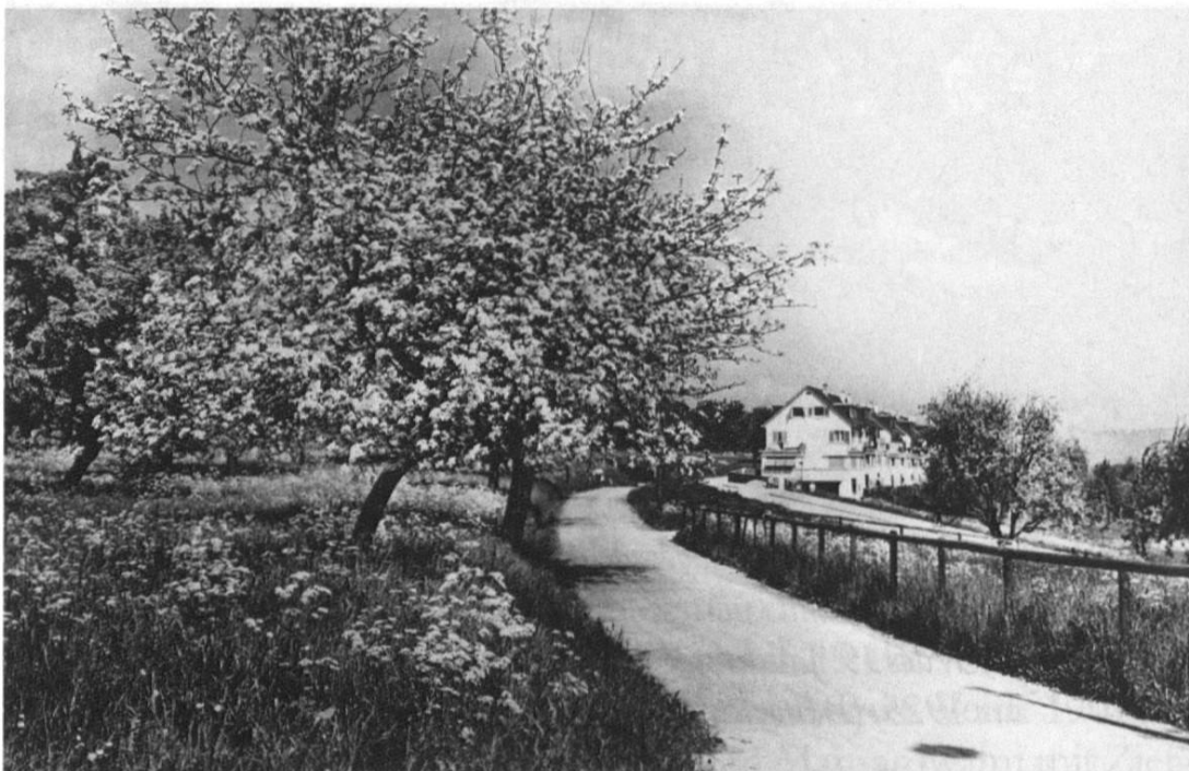
Abb. 11: Rainstrasse mit neu erstellter, einmündender Morgentalstrasse, Fruchtbaum und Moserhäuser in den Baumgärten, Aufnahme um 1924. (Baugeschichtliches Archiv der Stadt Zürich.)
