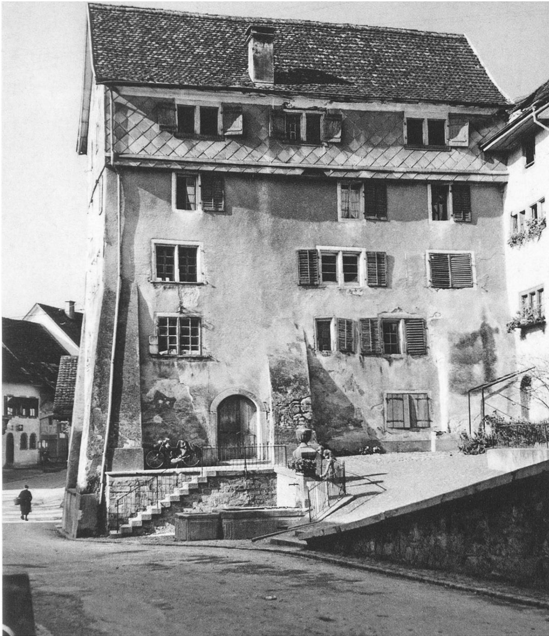
Abb. 1: Der «Pulverturm» in Eglisau, früher auch nach den Besitzern «Laufferhaus» und «Schneebelihaus» genannt. Von 1870 bis 1874 wohnte hier der gelernte Pulvermüller Rudolf Hartmann (geb. 1839), der in der unteren Küche des Hauses gefälschte Münzen herstellte. 1956 musste der markante Bau dem neuen Gemeindehaus weichen. (Foto: Ortsmuseum Eglisau.)
