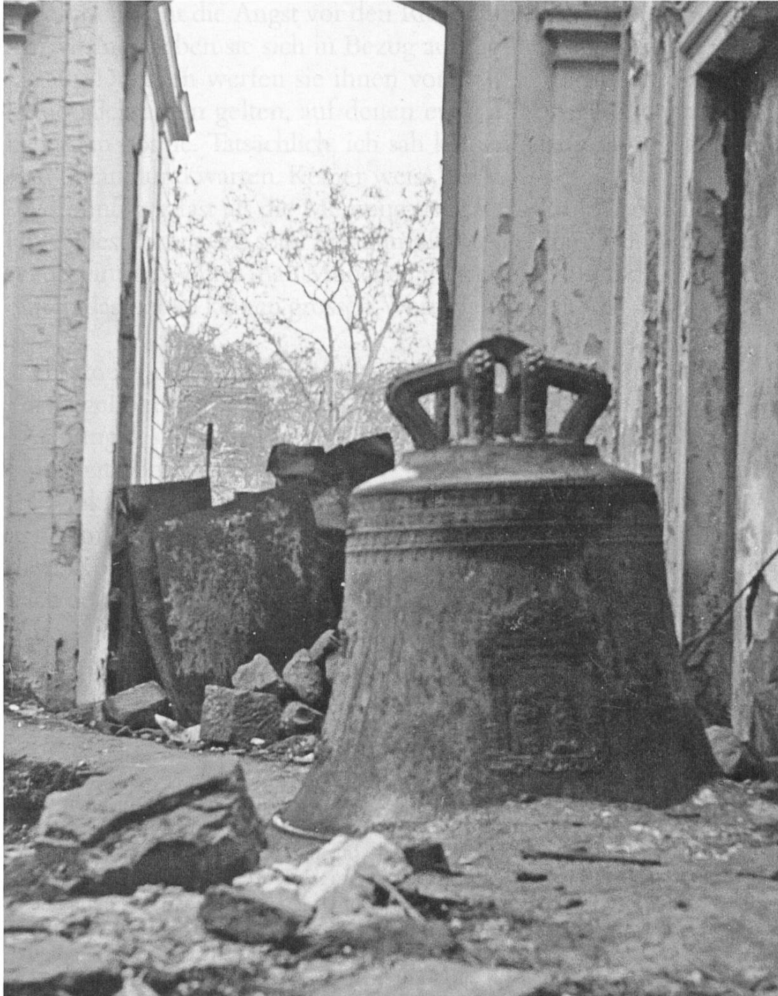
Abb. 7: Eine vom Turm in den Chorraum gestürzte Glocke, Zustand Juli 1945, Fotografie von Robert Hegglin.
